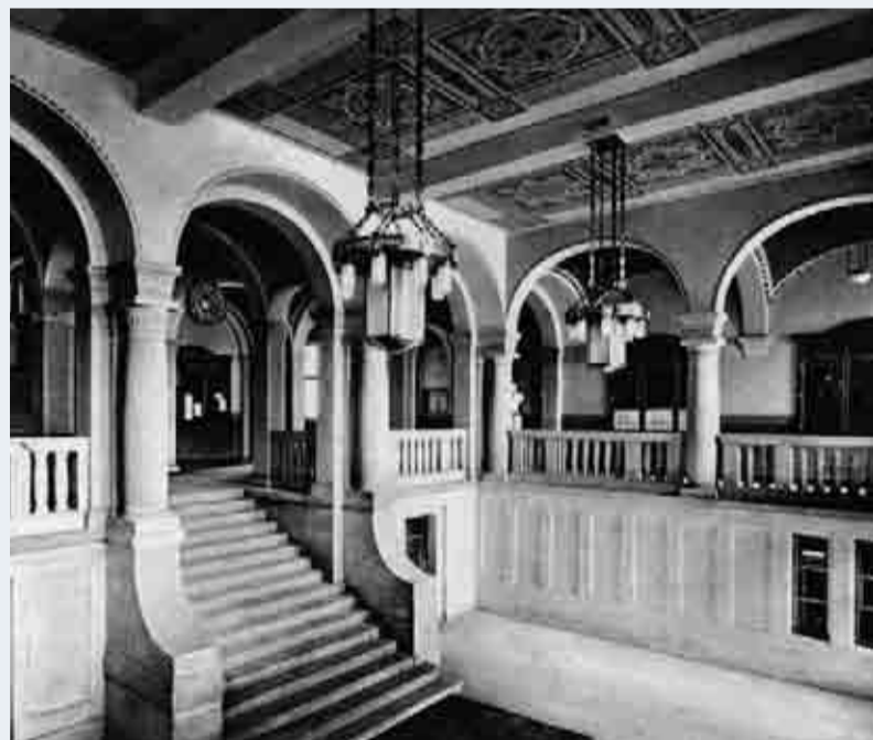
Innenansicht des alten Universitätsgebäudes in der Claudiustrasse. Hier ist das Römerparkfoyer zu sehen.
