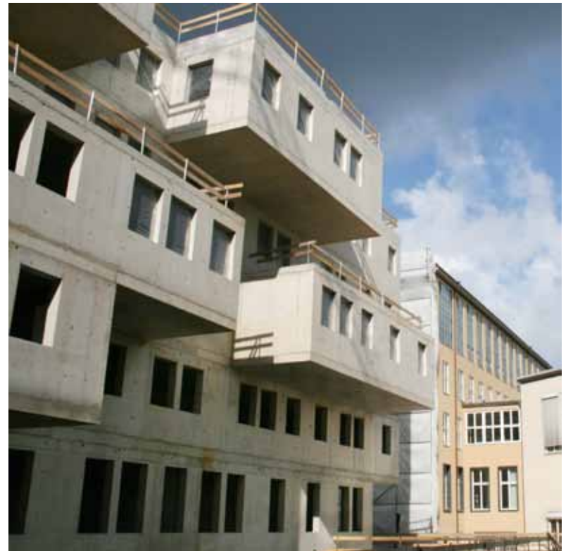
Der Rohbau steht. Bis 2013 wird das SSC bezugsfertig sein.
