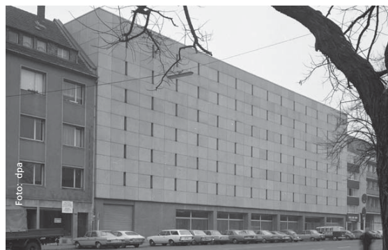
Das nun zusammengestürzte Gebäude des Archivs: In den 70er Jahren errichtet - Viel Beton, wenig Tageslicht.
